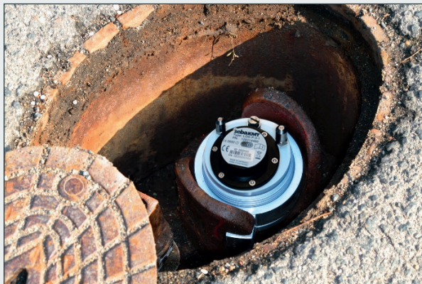
Sebalog P-3 in einem Unterflur-Hydranten
